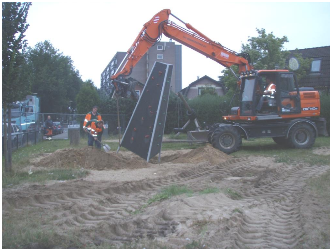
Afb. 4. Het verwijderen van de speeltoestellen, voorafgaand aan de sanering.
